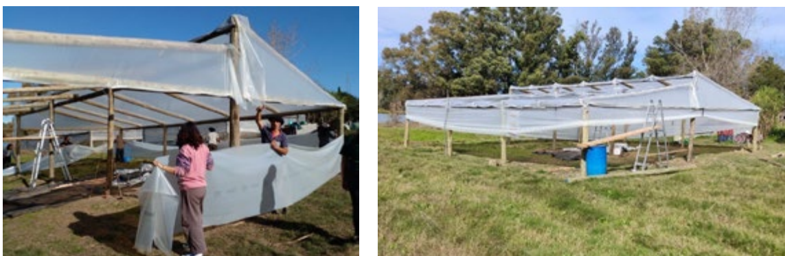
Figura 1: Izquierda: Colocación de polietileno sobre la estructura de madera durante el taller de diseño y construcción de invernáculos. Derecha: Invernáculo construido en el mismo taller, realizado en la escuela agraria de Durazno.
